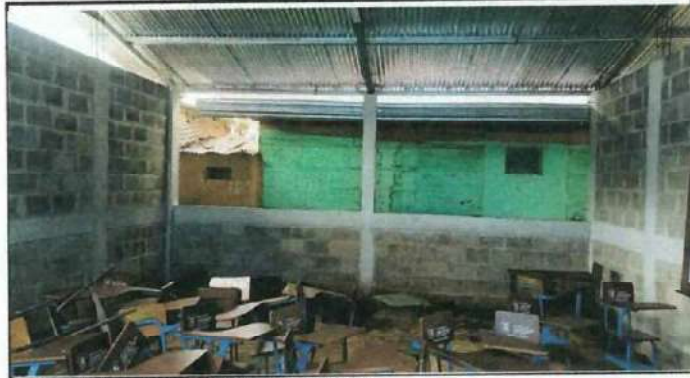
Foto 2: MODULO 2 VENTANAS Y PISO
