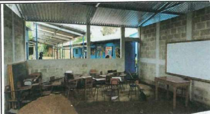
Foto1: MODULO 1 VENTANAS Y PISO
