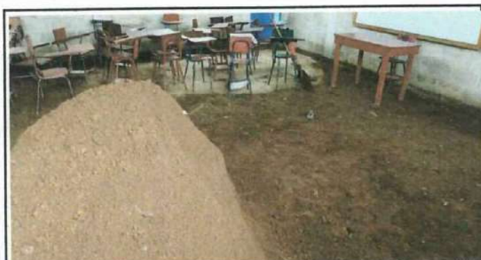
Foto 3: PISO MODULO 1 Y 2
